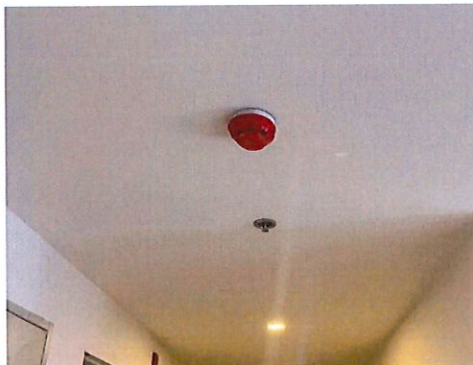
รูปที่ 44 เครื่องตรวจจับความร้อน (Heat Detector)
