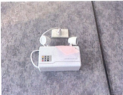
รูปที่ 33 ไฟฟ้าส่องสว่างฉุกเฉิน (Emergency Light)
