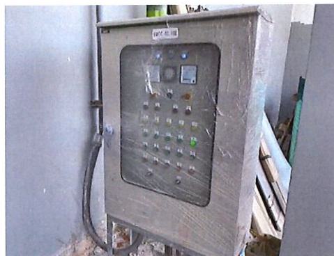
รูปที่ 13 ตู้ควบคุมระบบบำบัดน้ำเสีย
