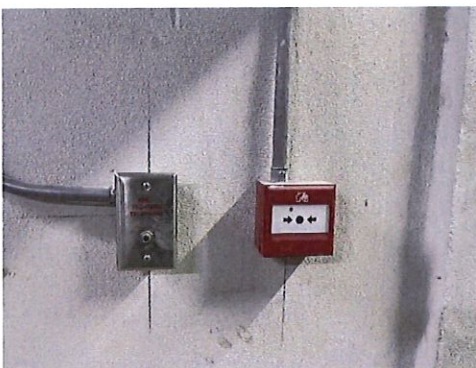
รูปที่ 46 โทรแจ้งเหตุฉุกเฉินเพลิงไหม้ (Telephone Jack)
