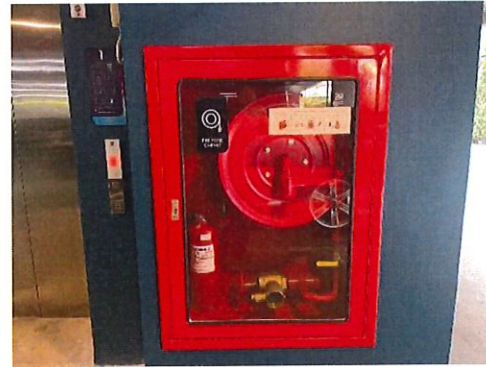
รูปที่ 38 ตู้เก็บสายฉีดน้ำดับเพลิงพร้อมอุปกรณ์ (Fire Hose Cabinet: FHC)
