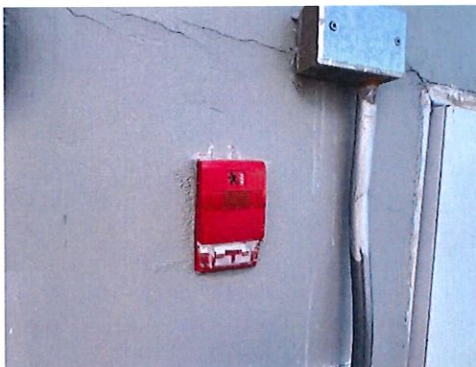
รูปที่ 46 โทรแจ้งเหตุฉุกเฉินเพลิงไหม้ (Telephone Jack)
