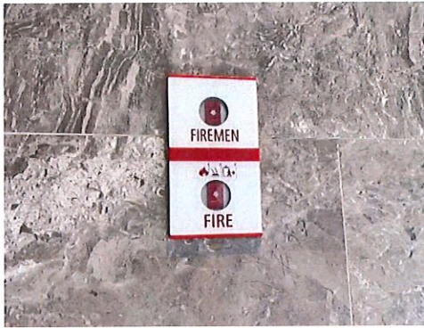
รูปที่ 45 เครื่องแจ้งเหตุโดยใช้มือตึง (Fire Alarm Manual Station)
