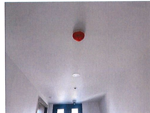
รูปที่ 44 เครื่องตรวจจับความร้อน (Heat Detector)
