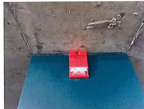
รูปที่ 46 โทรแจ้งเหตุฉุกเฉินเพลิงไหม้ (Telephone Jack)
