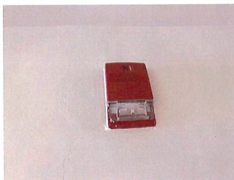
รูปที่ 47 เครื่องแจ้งเหตุด้วยแสง (Spraker With Strobe Light)
