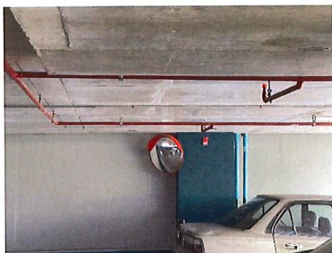
รูปที่ 40 ระบบหัวกระจายน้ำดับเพลิงอัตโนมัติ
