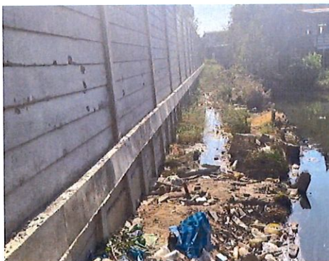
รูปที่ 6 กำแพงกันดินเขตติดต่อกองหิน
