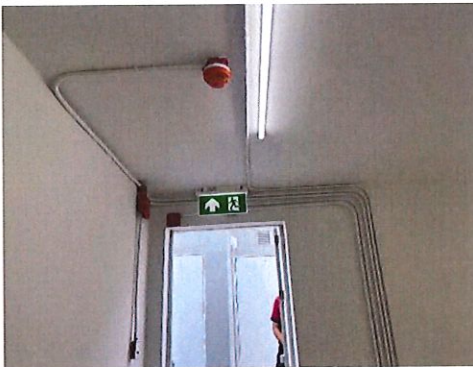
รูปที่ 43 เครื่องตรวจจับควัน (Smoke Detector)
