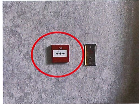
รูปที่ 45 เครื่องแจ้งเหตุโดยใช้มือตึง (Fire Alarm Manual Station)
