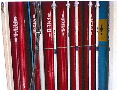
รูปที่ 36 ระบบท่อเย็น (Stand Pipe)
