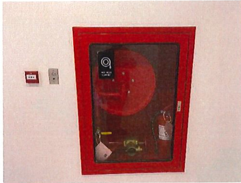
รูปที่ 38 ตู้เก็บสายฉีดน้ำดับเพลิงพร้อมอุปกรณ์ (Fire Hose Cabinet: FHC)
