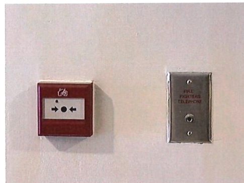
รูปที่ 46 โทรแจ้งเหตุฉุกเฉินเพลิงไหม้ (Telephone Jack)
