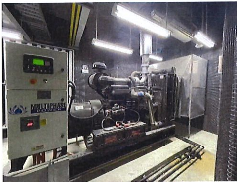
รูปที่ 32 เครื่องกำเนิดไฟฟ้า (Generator)
